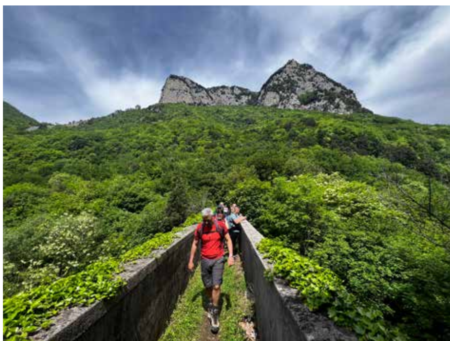
Figura 1 - Ponte Dell'Angelo sul Fiume Tusciano - Olevano sul Tusciano. Fotografia di Daniele Campanile - Explorer Campania
