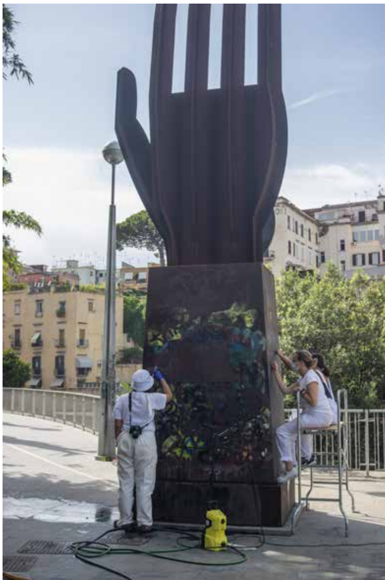
S. Rosa, Paladino, cantiere M. Nesi, 2022
