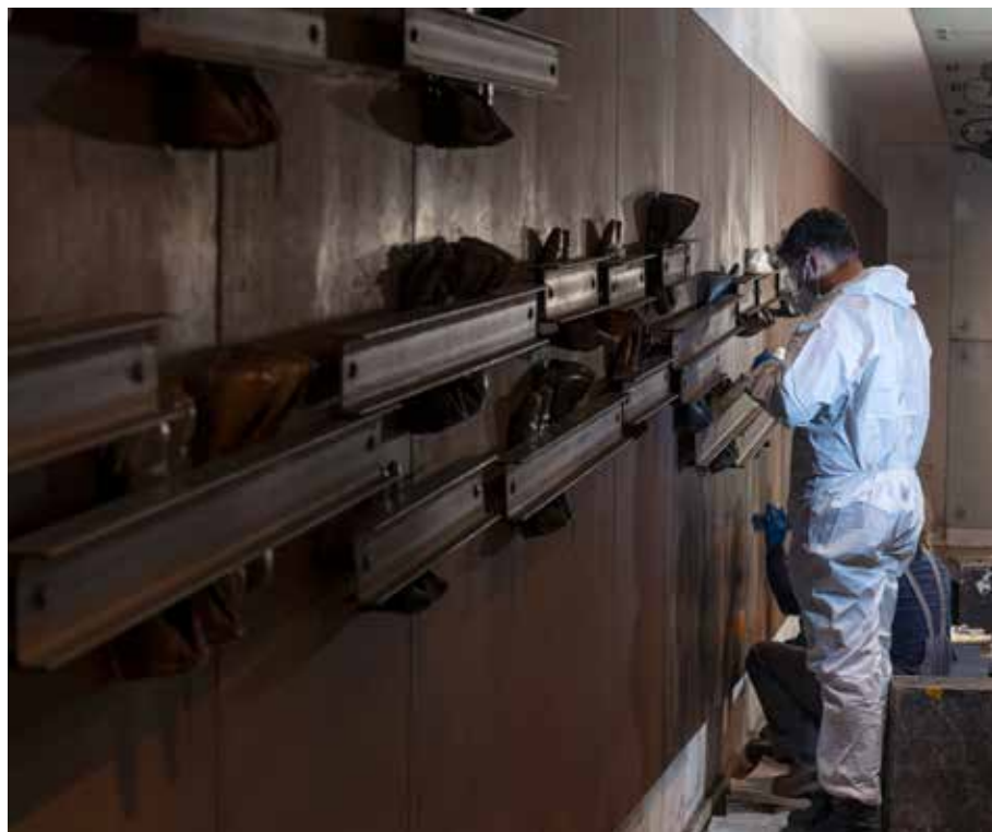
Stazione Dante, cantiere-scuola Accademia di Belle Arti restauro opera Kounellis
